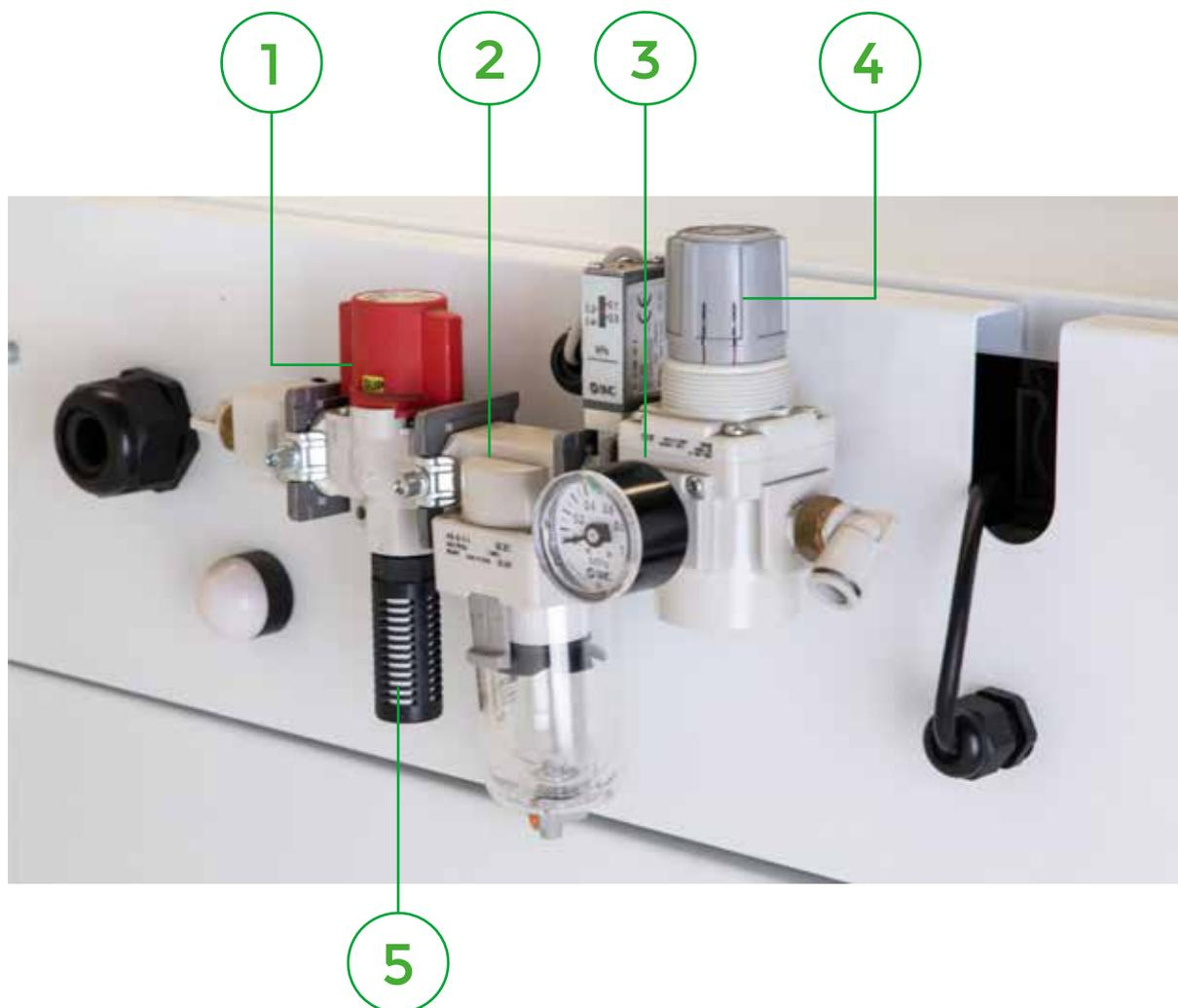
1. válvula de presión de presión 2. Switch de control de presión 3. Filtro de aire 4. Válvula de alivio 5. Silenciador.
