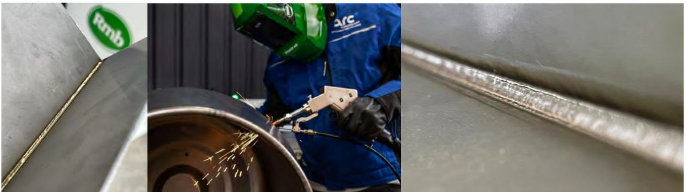
**ROLLOS DE ALAMBRE:** Los materiales de aporte utilizados son los mismos alambres sólidos que los que se utilizan en el proceso MIG-MAG. Pueden utilizarse rollos de hasta 15 kg.
